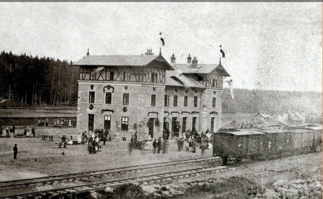
Nádraží Martinice v Krkonoších v době zahájení provozu na dráze Chlumeč nad Cidlinou – Trutnov
