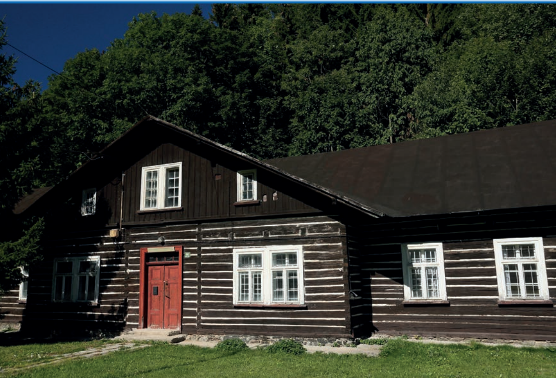
Dřívější obytný dům patřící ke sklárně v Temném Dole
