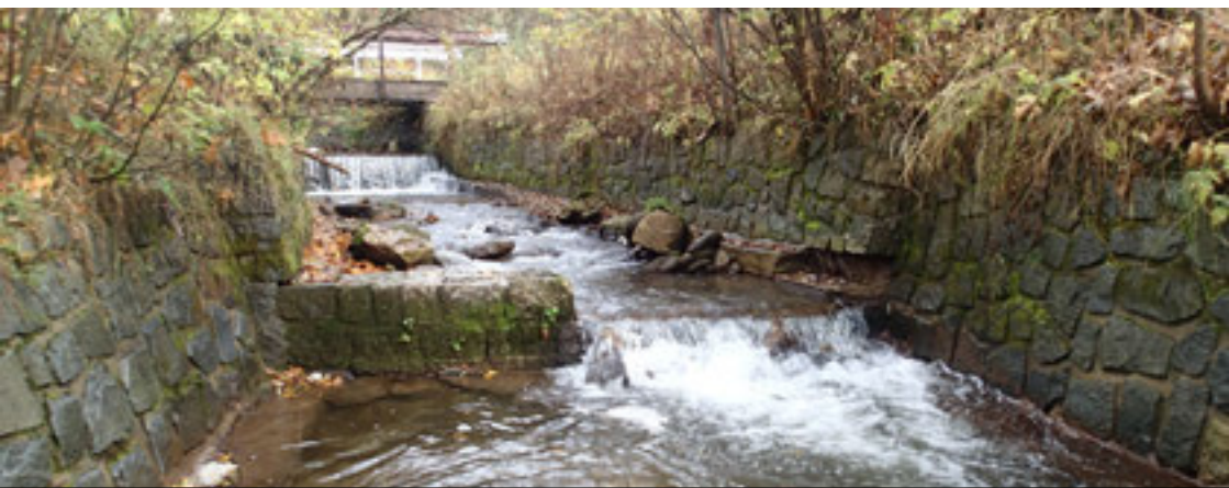
Ukázka původního stavu příčných stupňů jakožto migračních bariér, které byly předmětem zprůchodnění
