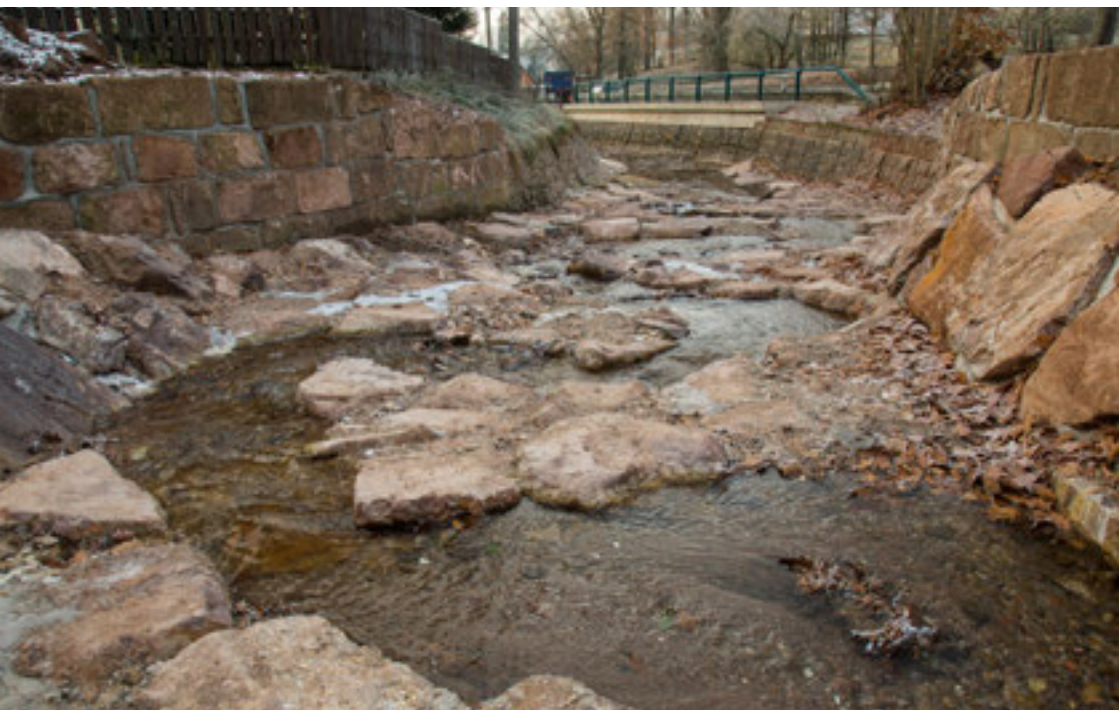
Realizace zprůchodnění betonového stupně na Bolkovském potoce – současný stav
