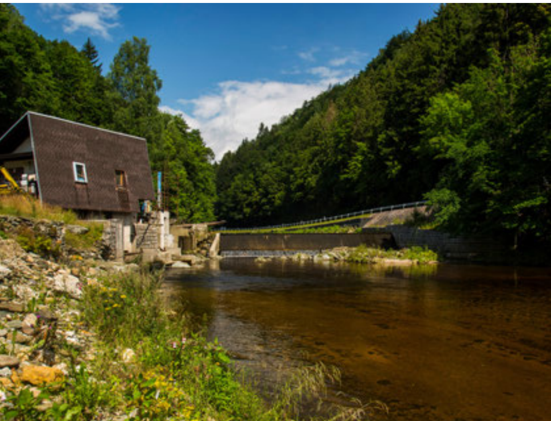
Jizera nad soutokem s Jizerkou – podjezí vzdouvacího objektu vody pro MVE. Ovlivnění sedimentačních procesů je patrné nejen v nadjezí, ale také v podjezí.
