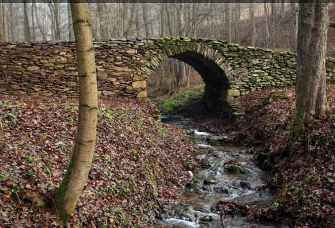
Kamenný most ve Sklenářovicích
