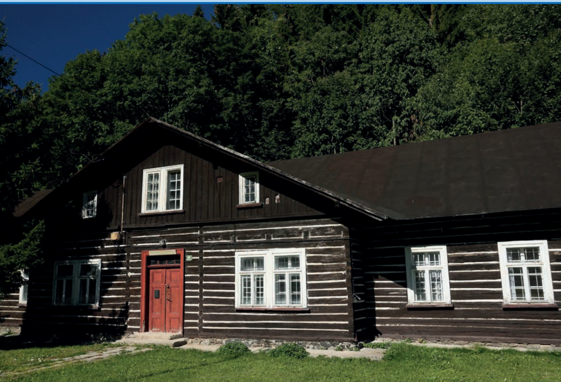
Wcześniejszy budynek mieszkalny należący do huty szkła w Ciemnym Dole [czes. Temný Důl]
