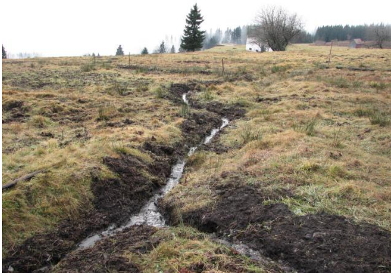
Foto č. 3: Obnova vodního režimu na Lahrových Boudách
