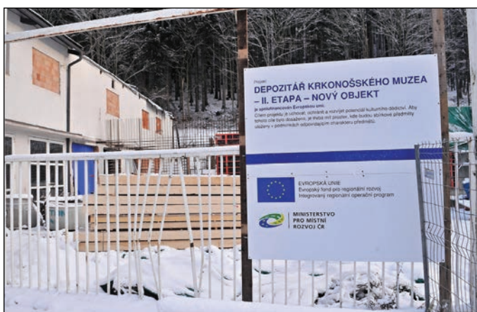
Staveniště budoucího deponitáře Krkonošských muzeí Správy KRNAP v Hořejším Vrchlabí
